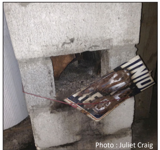
Figure 42. Exemple d'un conduit scellé par le bas alors qu'il devrait être scellé par le haut.
