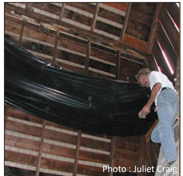
Figure 31. Des bâches ou des feuilles de plastique peuvent être utilisées pour collecter le guano.
